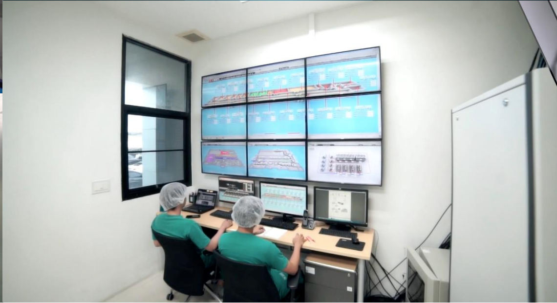
ระบบควบคุมและประเมินผลแบบศูนย์รวม SCADA : Supervisory Control and Data Acquisition
