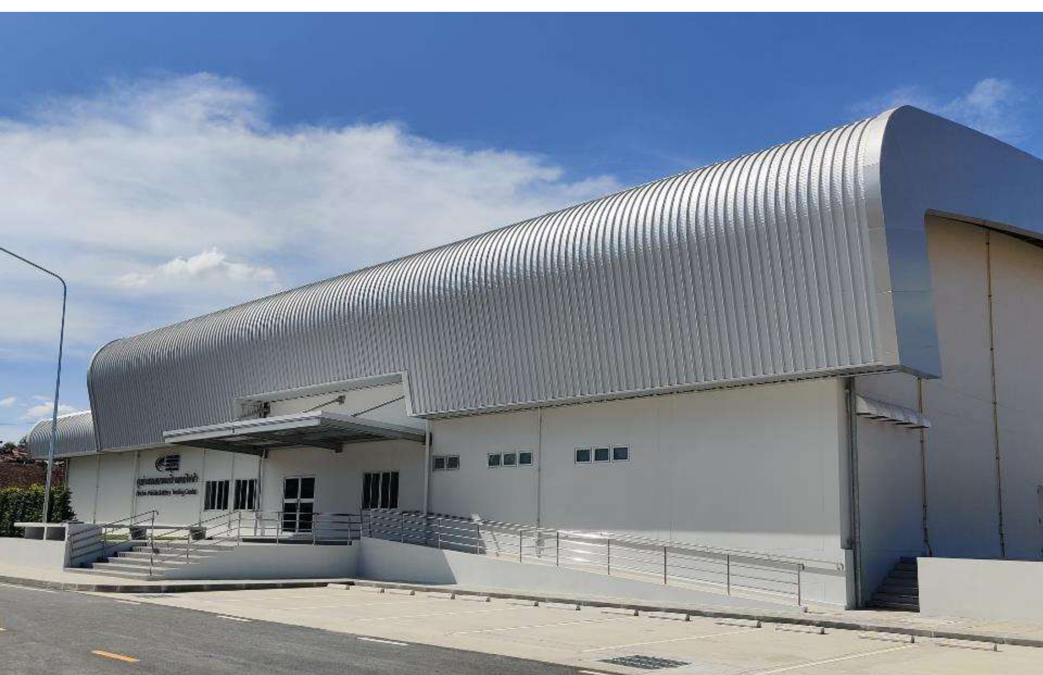
ศูนย์ทดสอบแบตเตอรี่ยานยนต์ไฟฟ้า สถาบันยานยนต์
