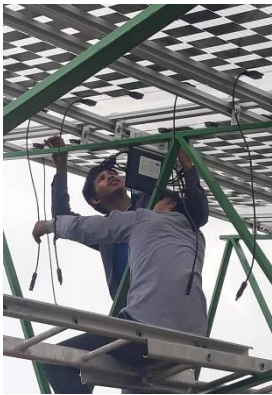
ติดตั้งไมโครอินเวอร์เตอร์
