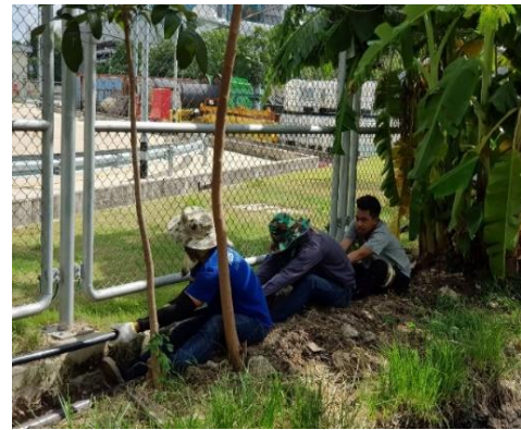
เดินสายไฟจากอาคารควบคุมไป ท075
