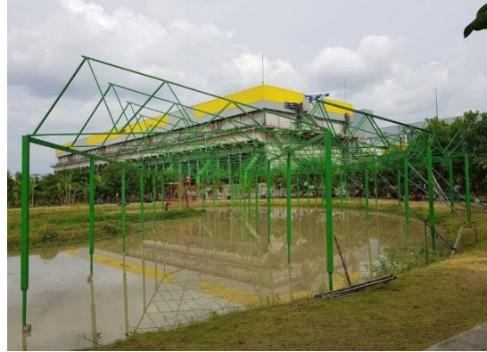
ติดตั้งโครงสร้างรองรับ
