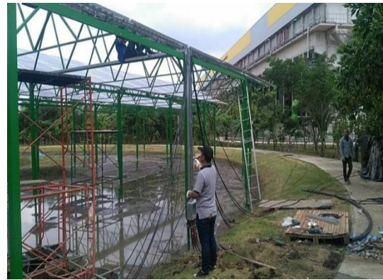
เดินสายไฟเข้าอาคารควบคุม
