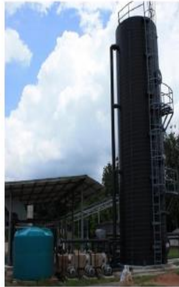
รูปที่ 7.8 แสดงลักษณะของถังกำจัดก๊าซไฮโดรเจนซัลไฟด์แบบ Biotrickling filter
