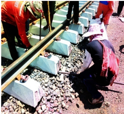
รูปที่ 9 การตีกิฟโดยใช้แรงงานคน
