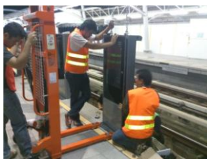
รูปที่ 3 การติดตั้งตัว HHPSD
