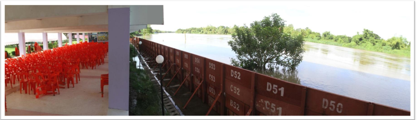
กำแพงป้องกันน้ำแบบยกพับเก็บที่โรงเรียนวัดกระแชง จ.พระนครศรีอยุธยา
