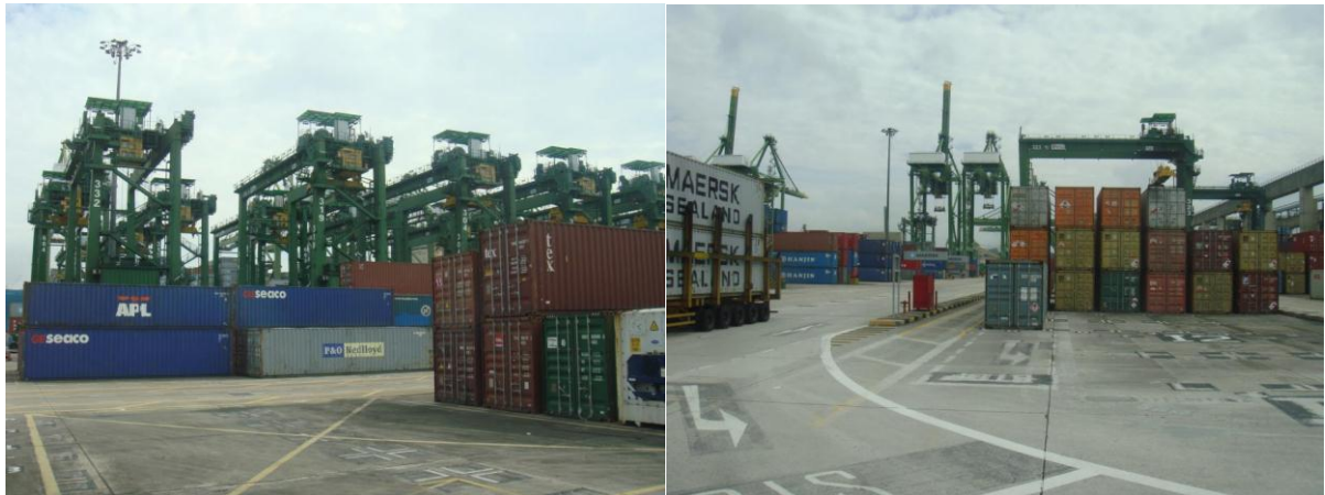
ระบบเครนยกตู้คอนเทนเนอร์แบบรีโมทคอนโทรล และจำนวนตู้คอนเทนเนอร์จำนวนมหาศาลภายในท่าเรือแห่งชาติสิงคโปร์
