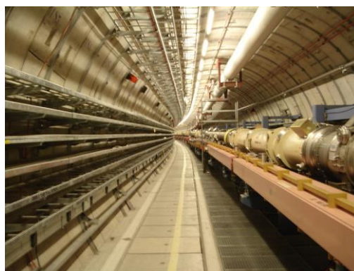
ภาพที่ 13 ส่วนเล็ก ๆ ของอุโมงค์ HERA ลำแสงโปรตอนกำลังเดินทางอยู่ในท่อสุญญากาศขนาดใหญ่ที่อยู่ตรงกลางไปทางขวาต่อลำอิเล็กตรอนจะอยู่ต่ำกว่านั้น
