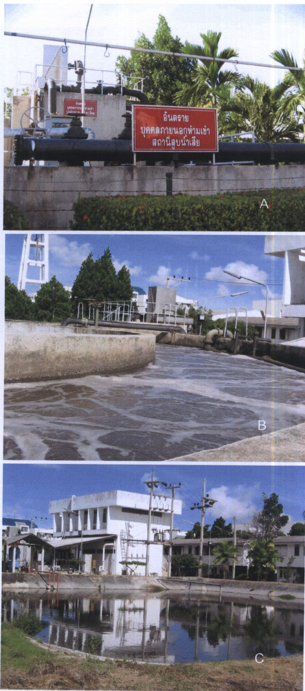
ภาพที่ 3 แสดงภาพถ่ายจุดเก็บตัวอย่างระบบบำบัดน้ำเสียของโรงพยาบาลสงขลา อำเภอเมือง จังหวัดสงขลา แบบตะกอนเร่งชนิด Extended aeration ประกอบด้วย 3 ส่วน คือ น้ำทิ้งดินที่ยังไม่ผ่านการบำบัด (A) น้ำทิ้งในถังเติมอากาศ (B) และน้ำทิ้งที่ผ่านการบำบัด (C)
