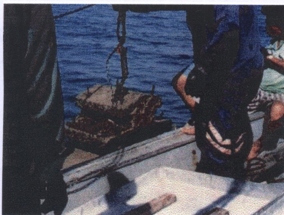
ภาพที่ 5 การยกปะการังเทียมขึ้นเรือด้วยเครื่องกว้านไฮโดรริก
