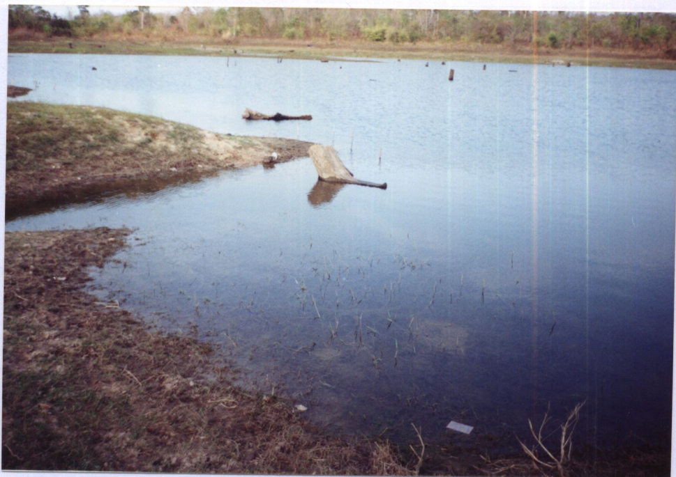
ภาพที่ 7 อ่างเก็บน้ำบ้านดอนใหม่ 1
