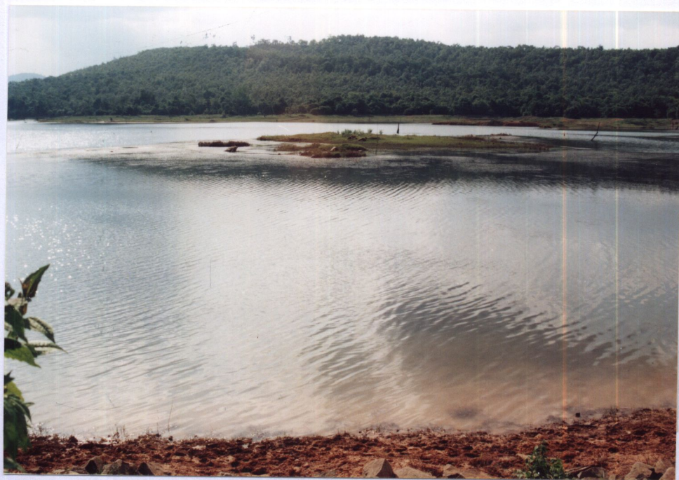
ภาพที่ 16 อ่างเก็บน้ำห้วยทราย 1
