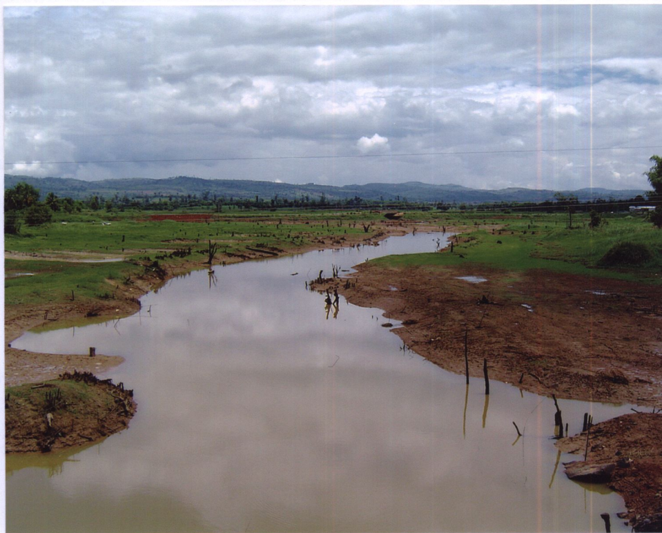
ภาพที่ 1 การสะสมของตะกอนดิน และทราย ในเขื่อนลำปะทาว จังหวัด ชัยภูมิ
